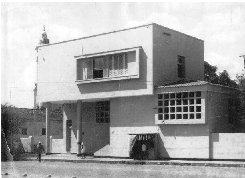
Antigo prédio dos Correios onde Serafim Nestor da Rocha, se aposentou
