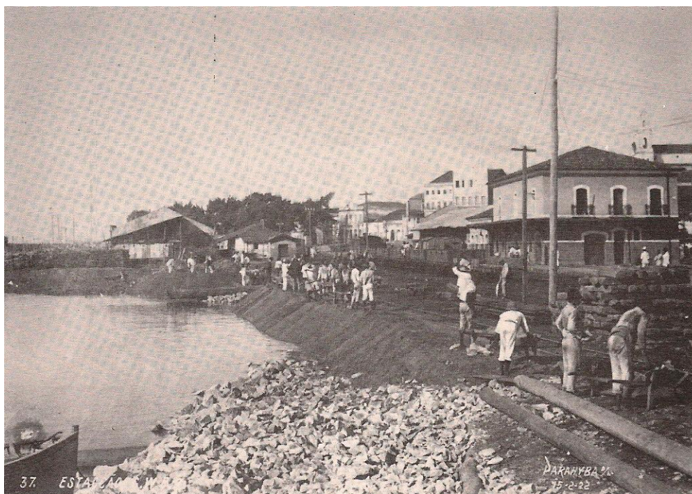
Foto 11: Obra do Porto Sanhauá – João Pessoa-Pb Fonte: Acervo de Humberto Nóbrega.
