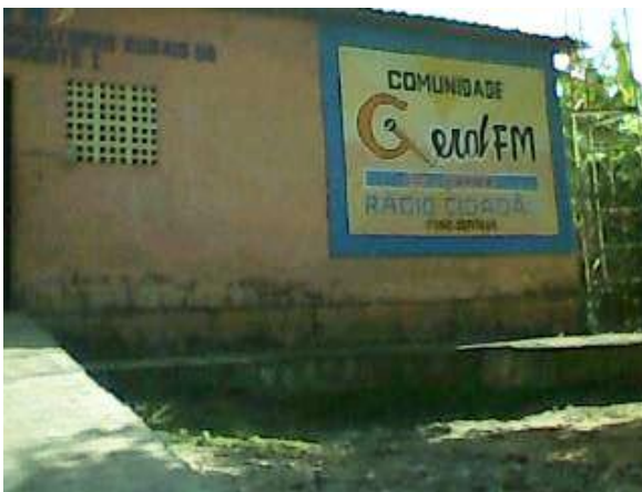
Figura 4 - Fachada da AMARBN onde funcionou a emissora até 2014
