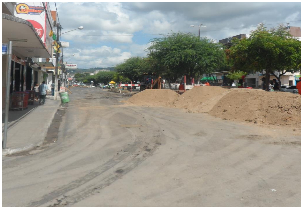
Figura 13: Andamento das obras de drenagem no Centro. Fonte: Arquivo Pessoal (18/11/14).
