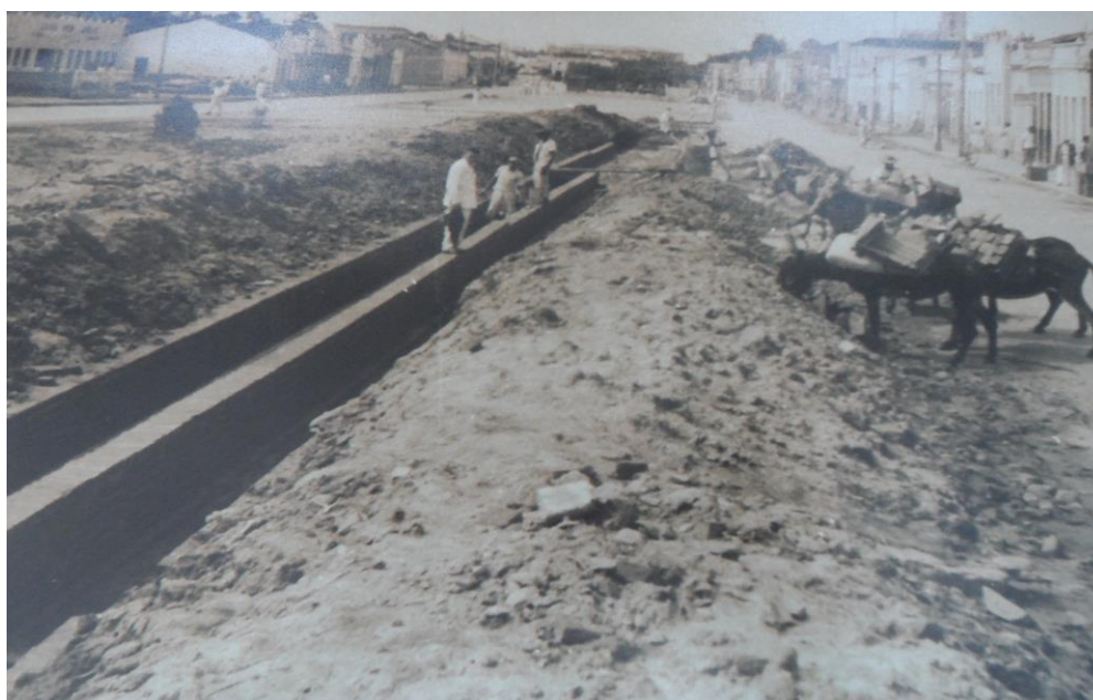
Figura 12: Construção de galerias no Centro, obra de infraestrutura em 1930. Fonte: Centro de Documentação Cel. João Pimentel de Guarabira/PB.
