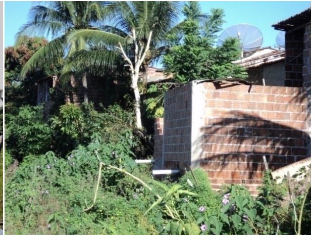
Foto 4: Construção de moradias e esgotos lançados ao rio Araçagi-PB. Fonte: Daniel Vieira de Souza. 13/03/2011
