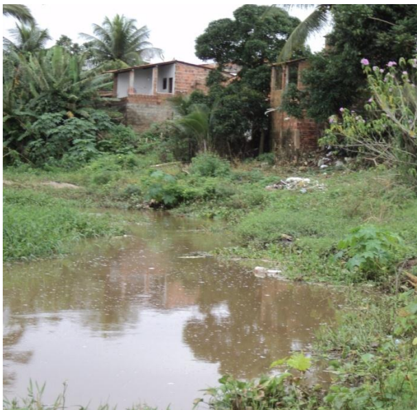
Foto 1: Construções irregulares nas margens do Rio Aracagi/PB. Fonte: Arquivo pessoal, 2013.
