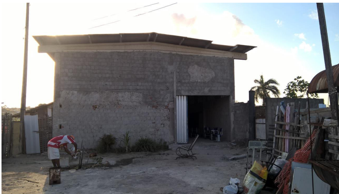
Figura 4. Galpão sede da ACATAVALE, local utilizado para o armazenamento dos materiais separados, reuniões e aulas de alfabetização do projeto Sal da Terra. Fonte: ROCHA, N.R.O.
