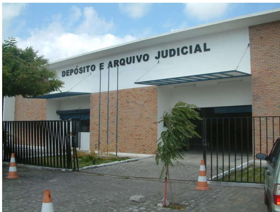
Figura 1 - Fachada do Arquivo do Fórum de Cabedelo
