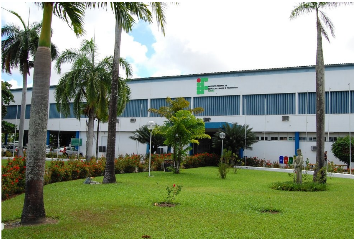
Figura 1. Vista da Fachada do Campus IFPB João Pessoa
