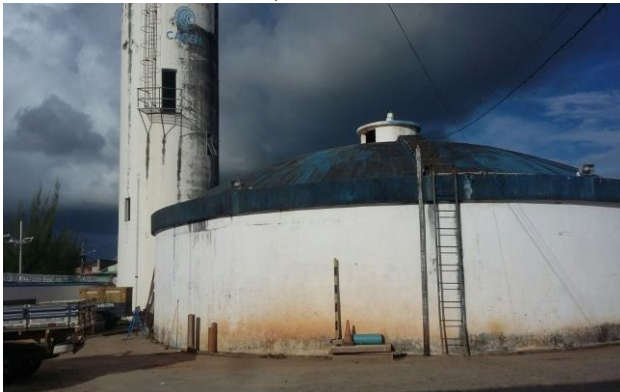
Figura 11: Reservatório elevado e apoiado Bairro Santa Terezinha 50Mil, Guarabira/PB/2017
