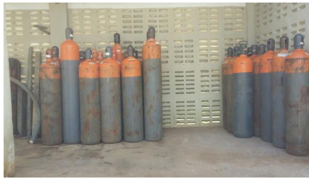
Figura 33: Etapas do tratamento de água na ETA da barragem Tauá, Cuitagi/PB - Cilindros de cloro gasoso/2017.
