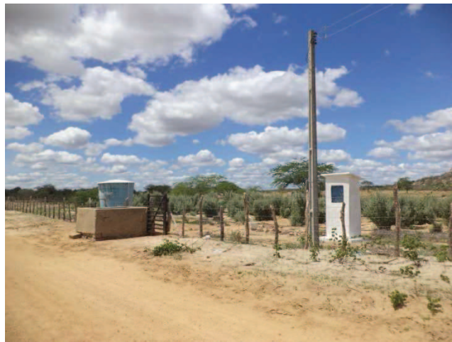
Figura 13 - Poço reformado e reativado.
