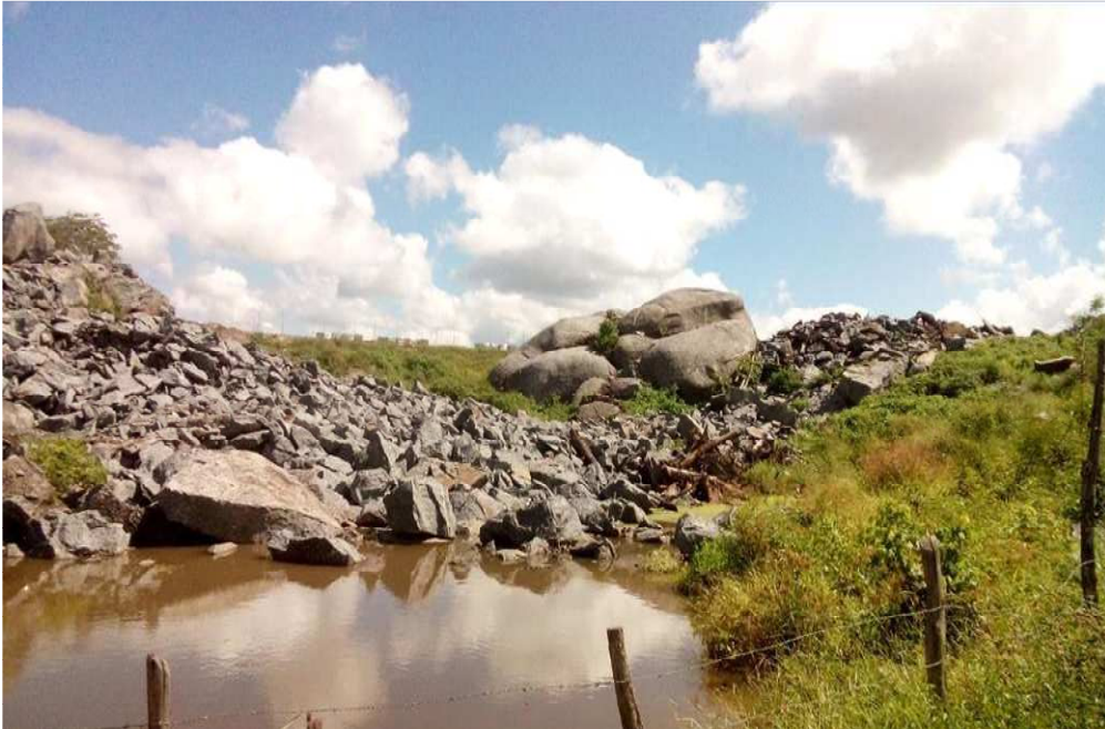
Figura 28. Percepção visual dos avanços das ações antrópicas na vegetação caatinga, com a construção do Complexo Multimodal Aluizio Campos, Campina Grande, PB.
