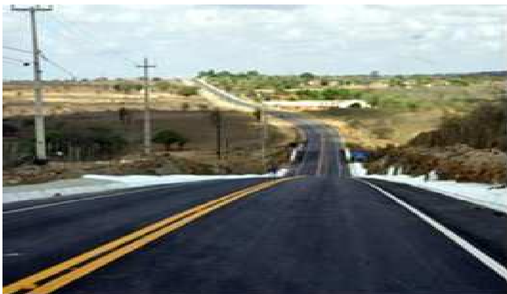
Figura 18. Degradação ambiental com a abertura de estradas
