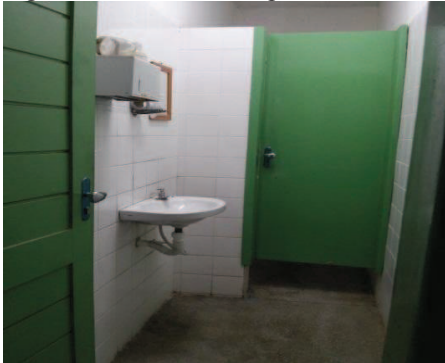
Figura 17: Banheiro dos professores
