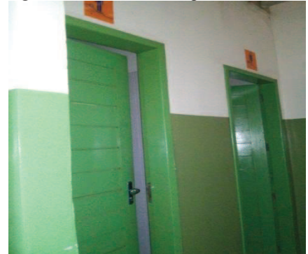
Figura 18: Banheiro dos professores
