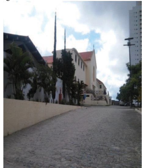
Figura 08: Estacionamento do Seminário.
