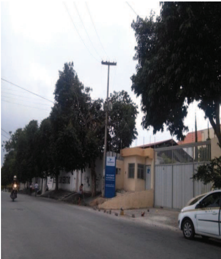
Figura 07: Fachada do Seminário
