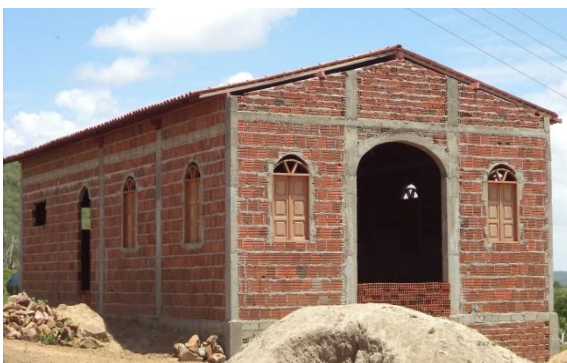
Figura 11: Fonte: Arquivo pessoal 2017. Capela em construção, Nossa S a das Vitorias.
