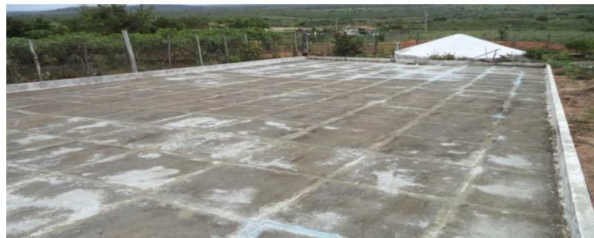
Figura 16: Fonte: Arquivo pessoal 2017. Cisterna-calçadão.
