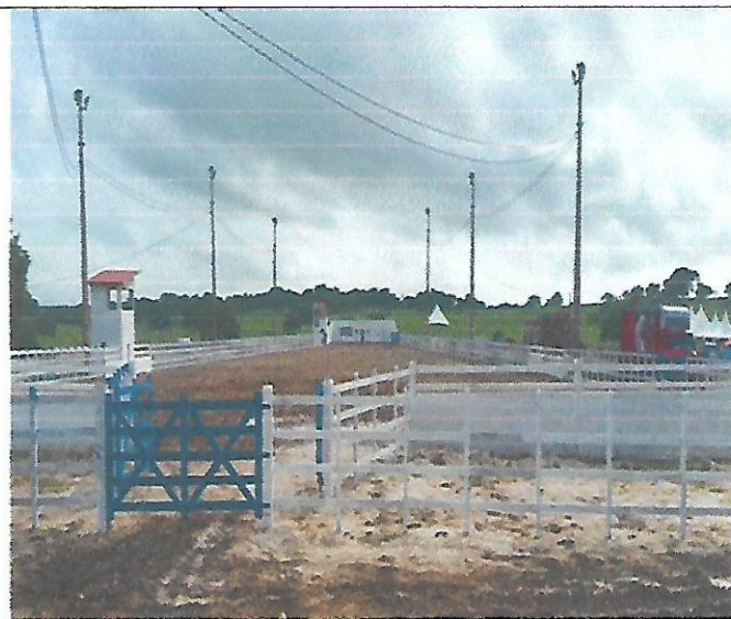
Imagem 03- Parque de Vaquejada Francisco Félix. Estrutura segue padrões estabelecidos. Fonte: Arquivos da autora
