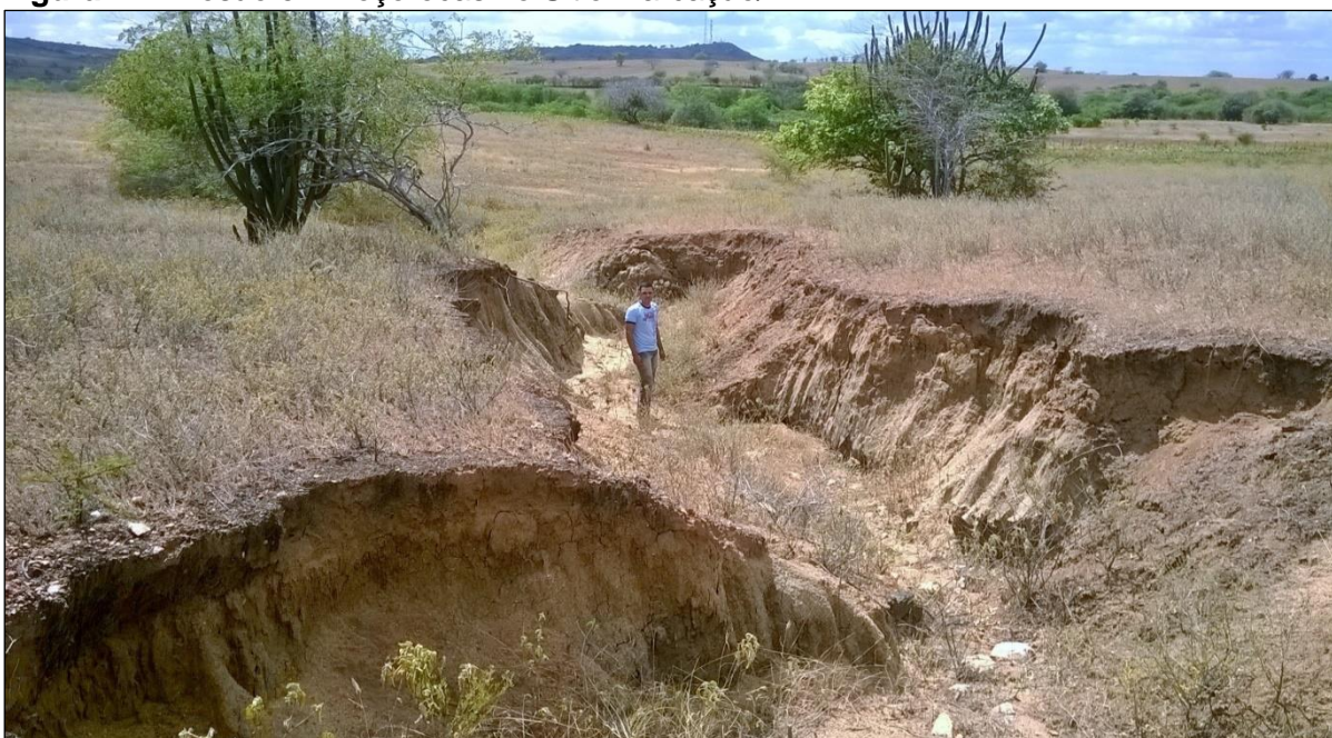
Figura 11: Erosão em Voçorocas no Sítio Marcação/RN.
