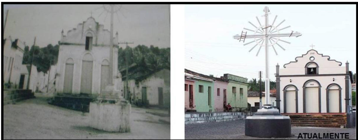
Figura 3: Capela/ atual igreja mãe, Dona Inês, 2017. Fonte: Maria Nilma Pereira Borges. Em setembro de 1972 o Padre José Floren chegou à cidade e vendo a necessidade de uma igreja maior, no ano de 1975, iniciou a construção de uma nova
