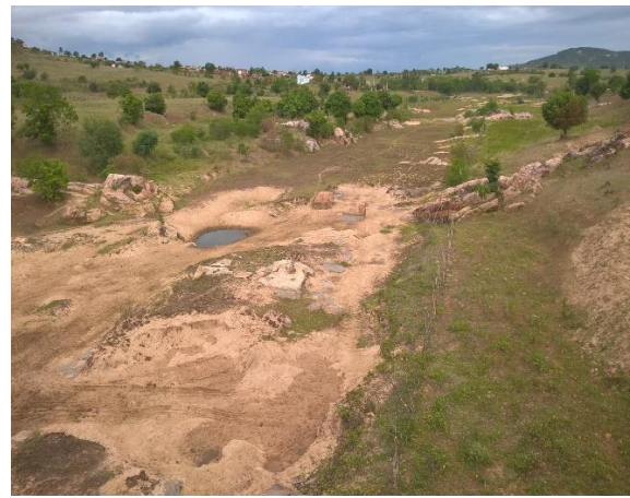
Figura 05: Rio Curimataú PB, ponte sobre a Rodovia PB-073 no ano de 2017. Fonte: Arquivo Pessoal.
