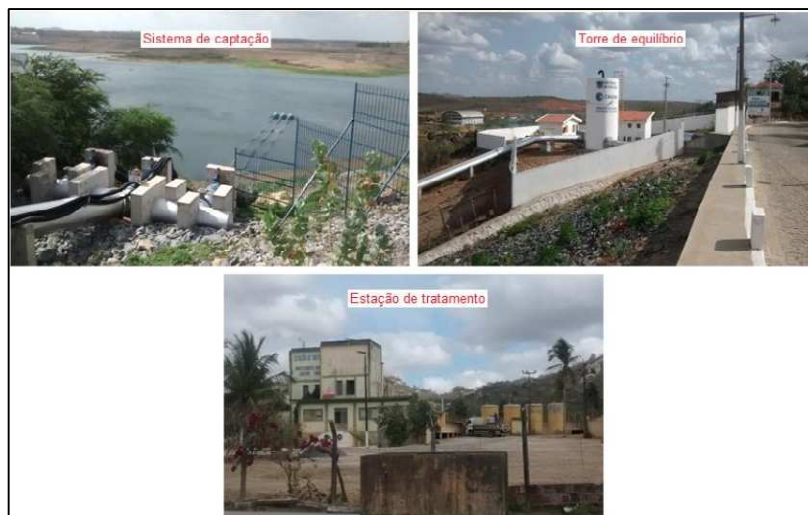
Figura 10 - Sistema de Captação Flutuante de Água do Açude Epitácio Pessoa.
