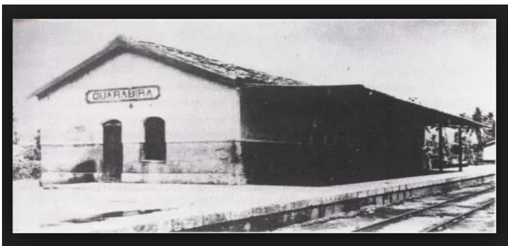
FIGURA 01: Antiga Estação Ferroviária de Guarabira/PB, 1984-1979.
