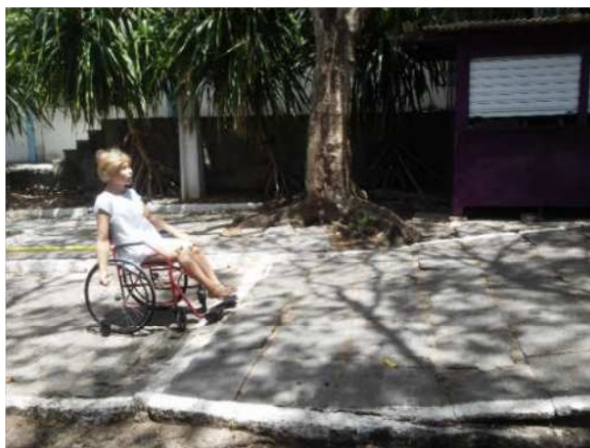
Figura 17 – Acesso alternativo à entrada no CCT.
