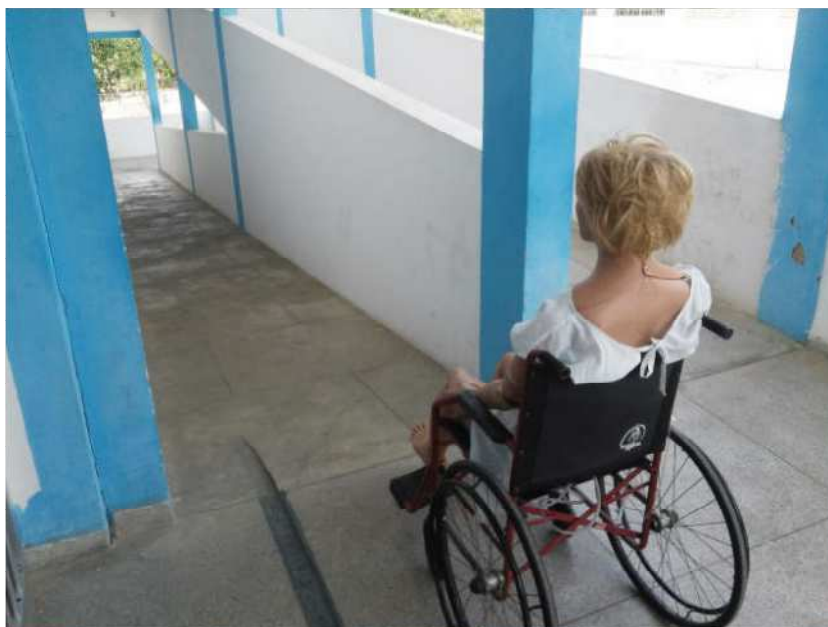
Figura 20 – Rampas de acesso existentes no bloco 3.
