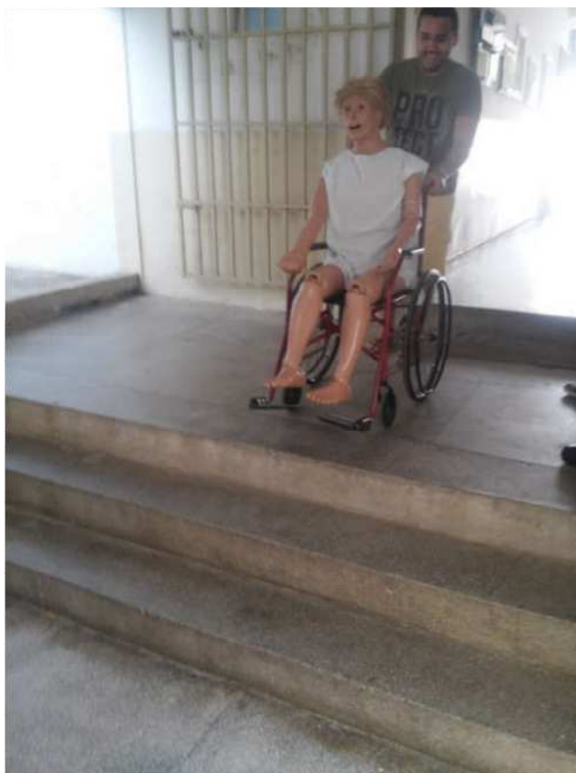
Figura 16: Impedância na transição entre blocos 1 e 2.
