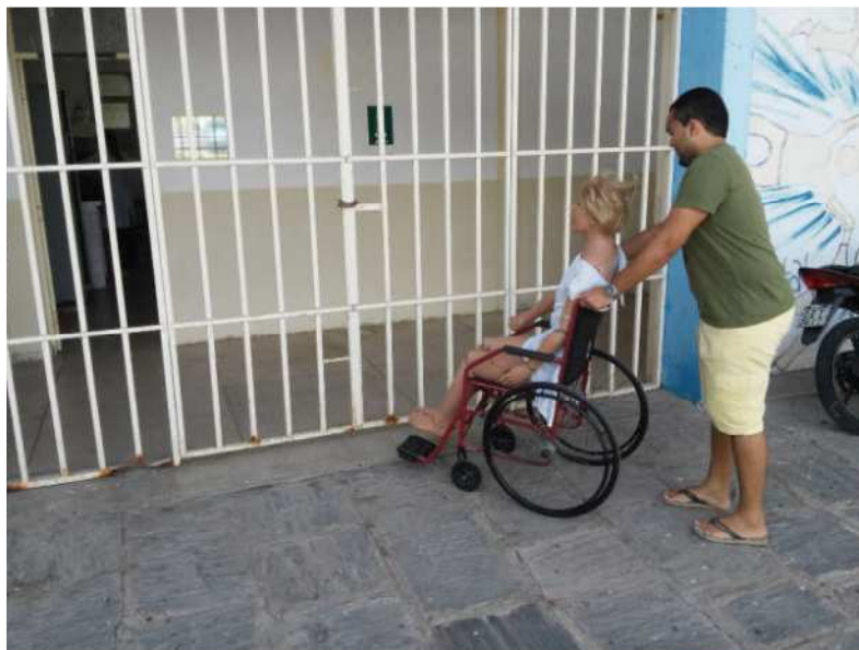
Figura 11 – Acesso de entrada ao bloco 1 bloqueado.
