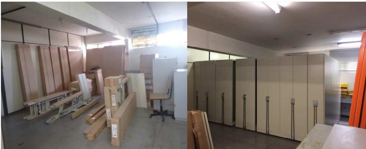
Figura 18: Instalação das Estantes Deslizantes em Fevereiro de 2017
