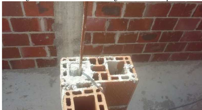
Figura 04 – Bloco cerâmico com graute e armadura passiva
