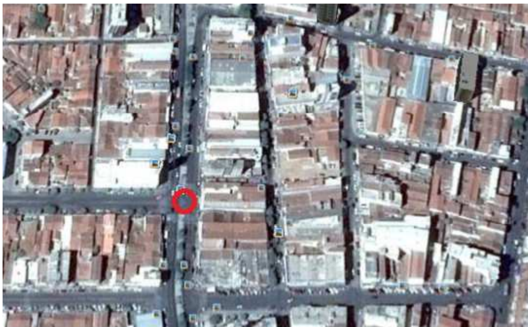
Figura 15: Ponto de Semáforos selecionados na Avenida Solon de Lucena, Patos - PB
