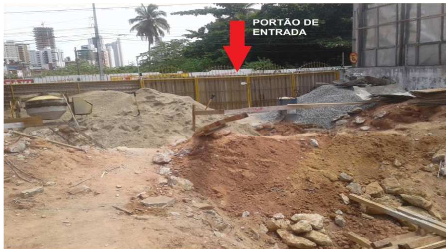
Figura 1 – Vista do portão de entrada da obra
