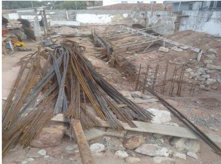
Figura 4 – Armazenamento de aço
