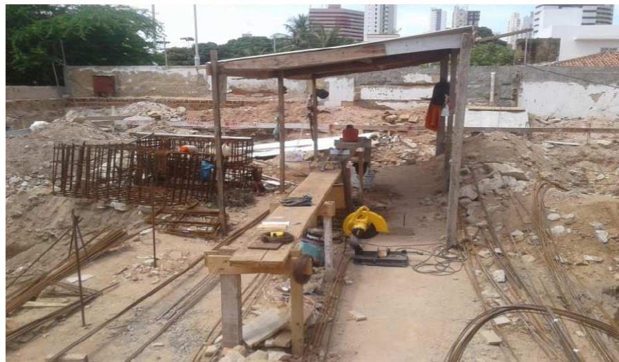
Figura 3 – Bancada de corte e dobra de aço
