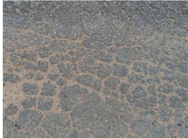
Figura 6 - Trinca interligada – tipo jacaré.
