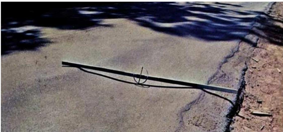
Figura 7 - Afundamento de trilha de roda.
