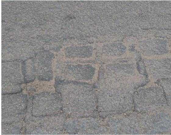
Figura 5 - Trinca interligada – tipo bloco.
