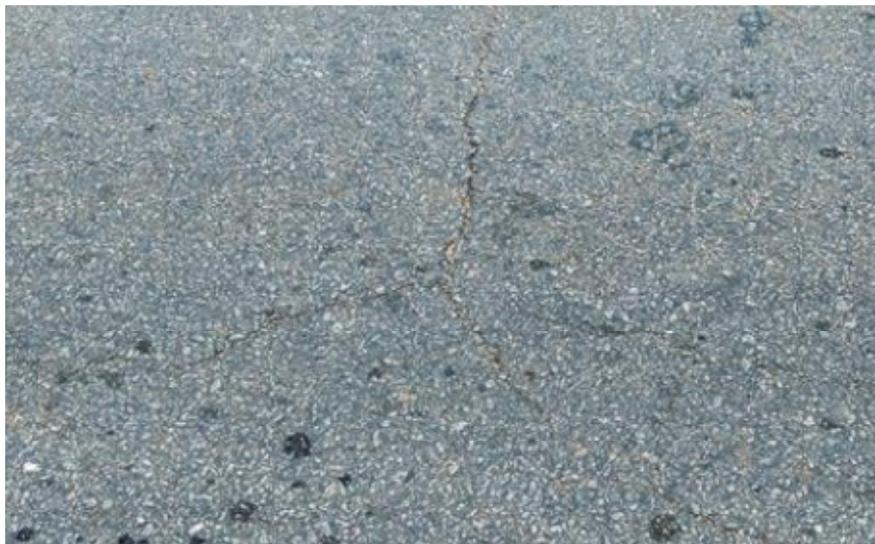
Figura 3 - Trincas interligadas.
