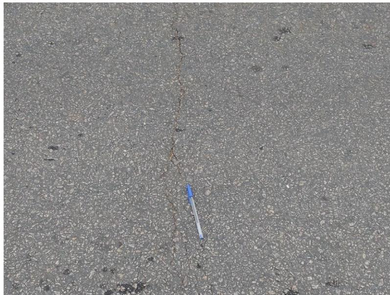
Figura 4 - Trincas transversal curta.
