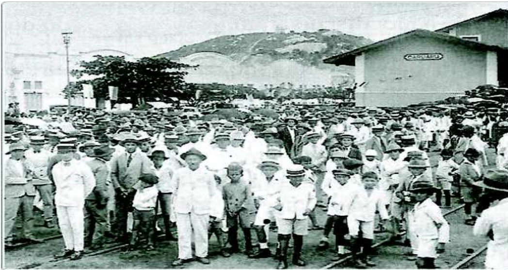
Foto N° 4 Multidão aguardando o trem- Estação de Caruaru -1895
