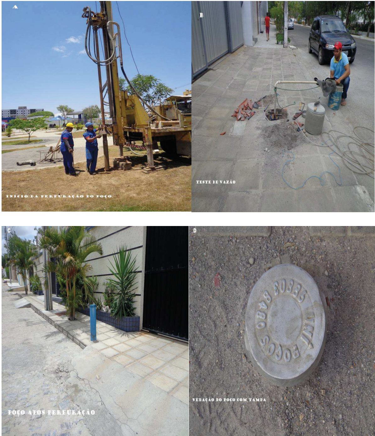
Figura 14- Processo de inicio e fim da perfuração do poço. A,B,C,D.
