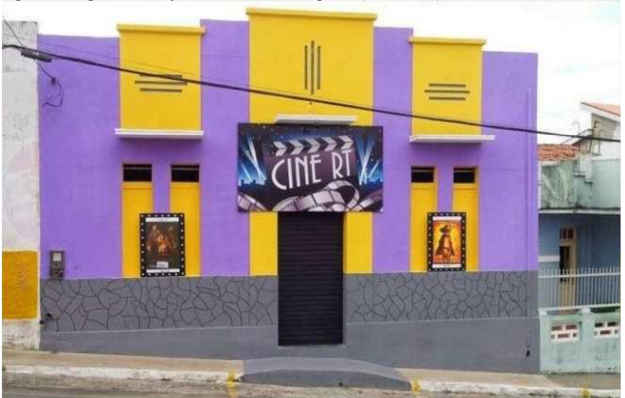
Figura 9: Antiga fachada do prédio do Cine RT, Remígio/PB (2012 – 2016)
