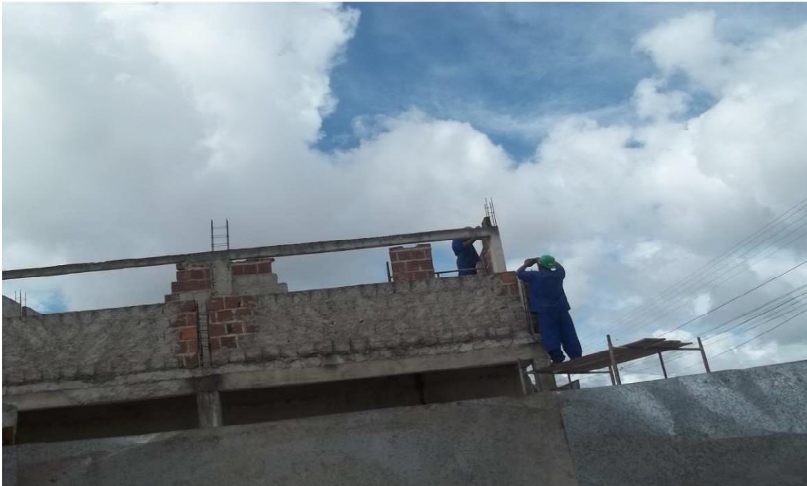
Foto 13: Obra em Andamento
