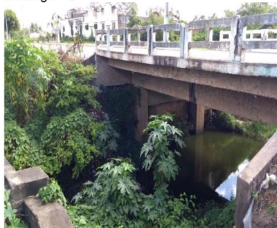
Figura 5 - Ponte no perímetro urbano de Mulungu-PB
