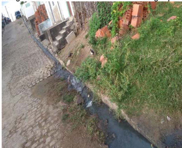
Figura 8- Esgotos a céu aberto direcionados as margens do rio Mamanguape.
