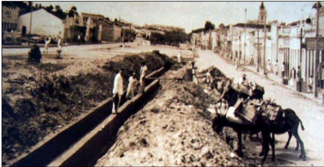
Figura 04 – Obras das Primeiras Galerias Pluviais nos anos 30
