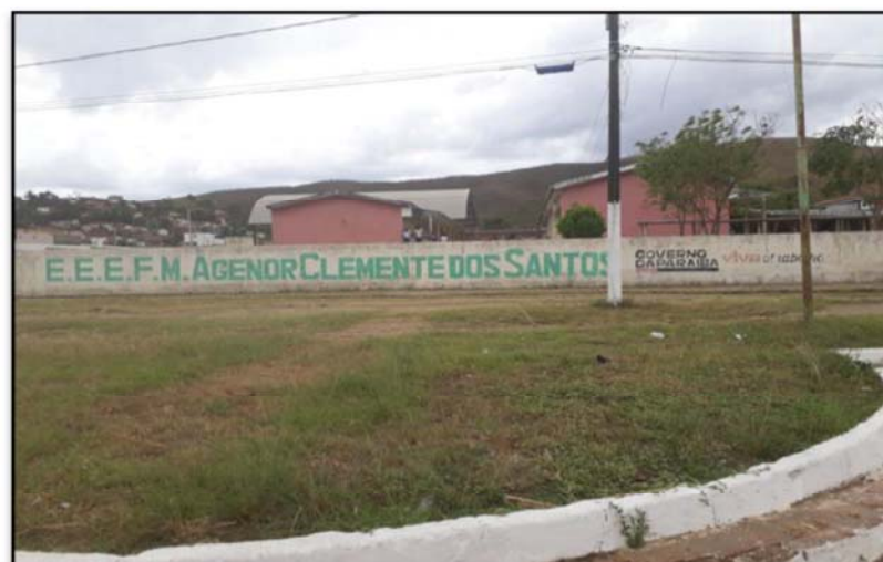
Figura 01- Imagem da fachada de frente da escola.
