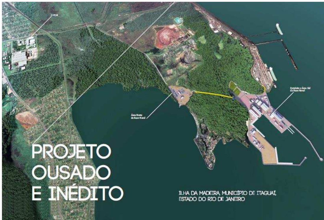
Figura 6 – Complexo de Infraestrutura Naval
