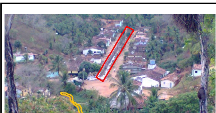
Fotografia 10: Vista aérea da comunidade. Ao centro encontra-se o canal que retém as águas dos esgotos e na parte inferior o leito do rio que recebe essa água poluída.
