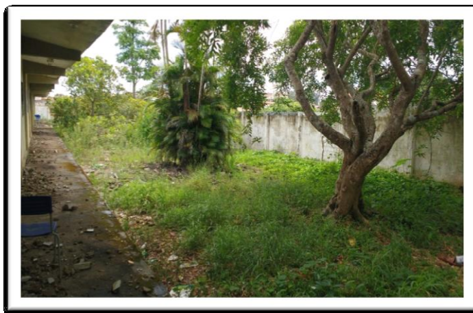
IMAGEM 6 – MURO DE ISOLAMENTO
