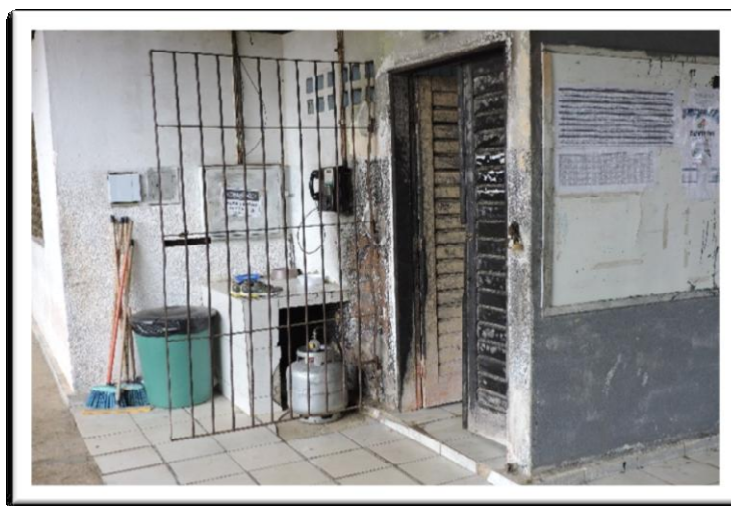
IMAGEM 5 – ENTRADA DA COZINHA
