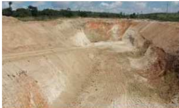
Figura 11. Construção do aterro sanitário na usina do município de Esperança/PB.
