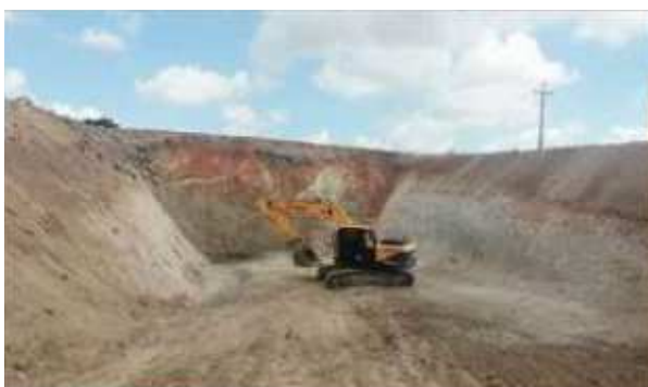
Figura 10. Escavação para o aterro sanitário na usina do município de Esperança/PB.
