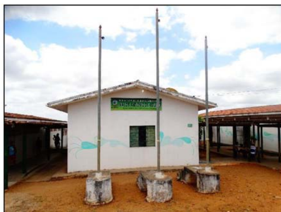
Figura 38 – Parte interna da escola
