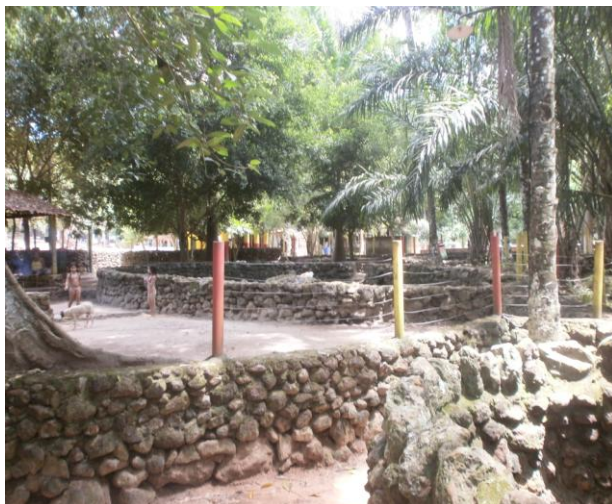
Figura 24 – Rocha “vulcânica” empregada na construção do balneário da Piscina da Nascença.
