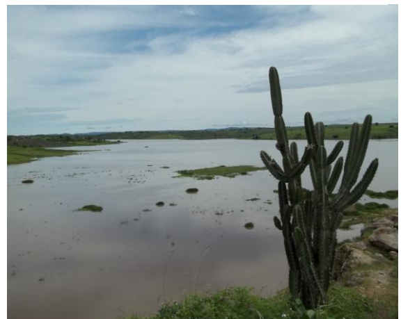
Figura 32 – Vista da barragem de Aruá.
