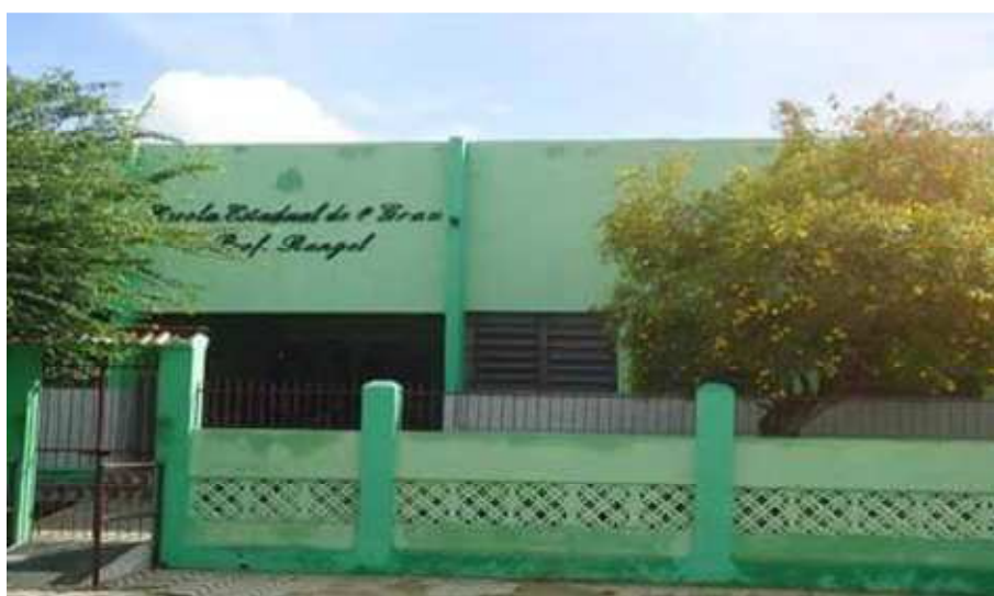
Figura 4: Fachada da Escola Estadual de Ensino Fundamental Professor Rangel
