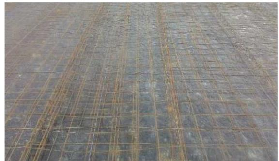
**d) Detalhe do posicionamento da armadura finalizada.**
