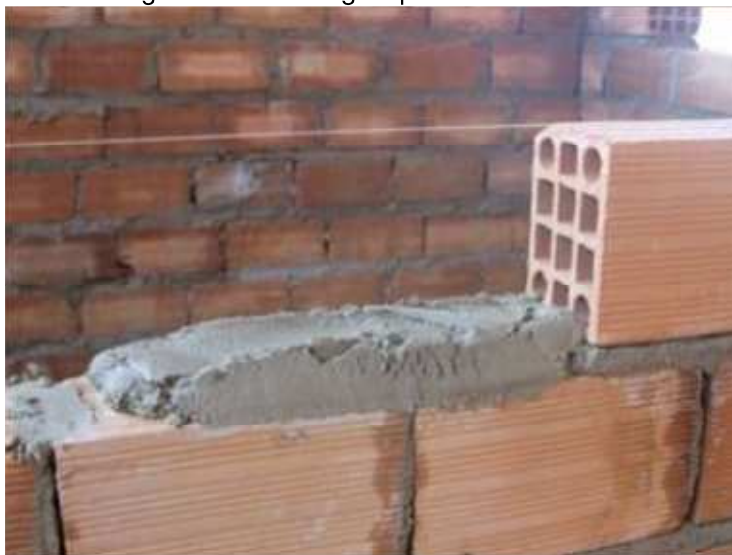
Figura 4: Linha de guia para assentamento
