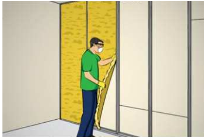
Figura 18: Isolamento termo-acústico
