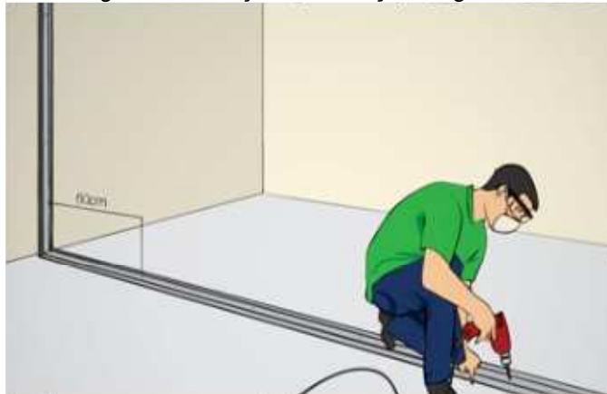
Figura 13: Fixação e marcação da guia
