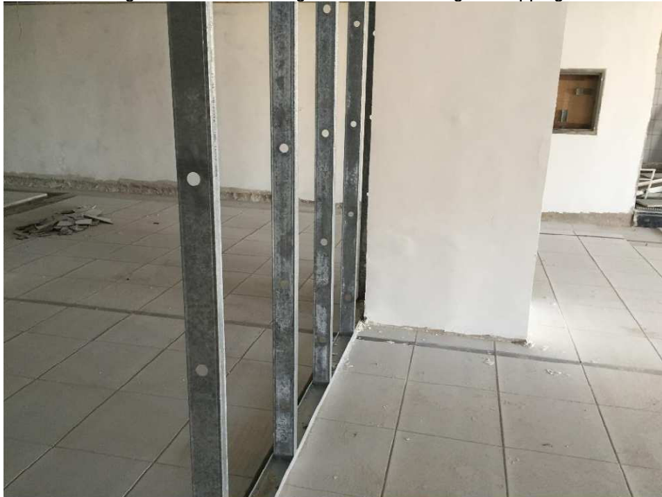
Figura 26: Montante e guias de 70 mm Lagoa shopping
