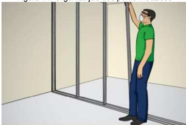
Figura 14: Organização dos perfis metálicos
