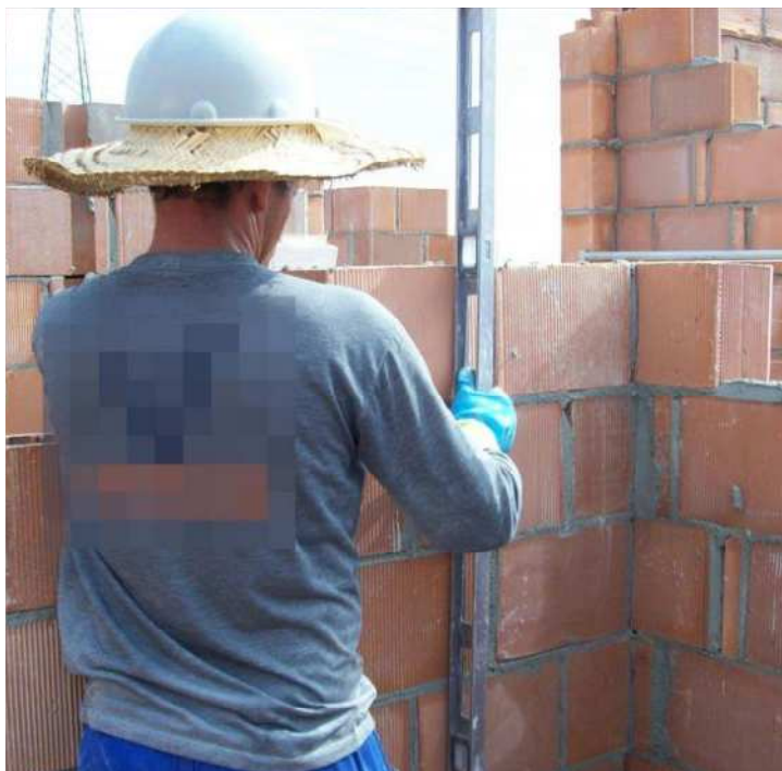
Figura 5: Verificação de prumo e alinhamento de uma parede
