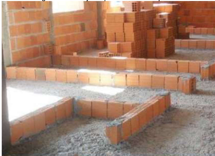
Figura 3: Marcação e primeira fiada de paredes
