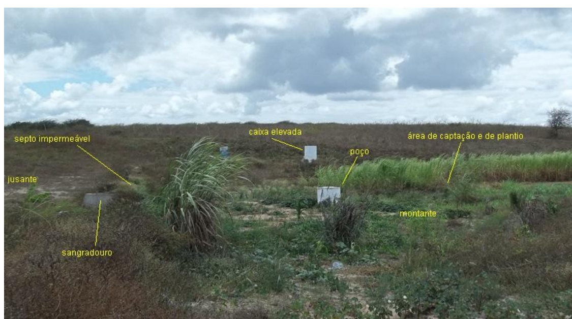
Figura 9. Barragem subterrânea 4 construída pela AS-PTA. Fonte: Acervo do autor, 11/2011.
