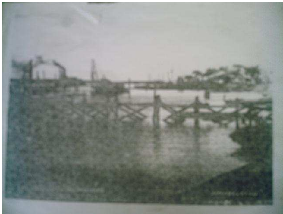
FOTO 34: Construção do cais provisório (1922)
