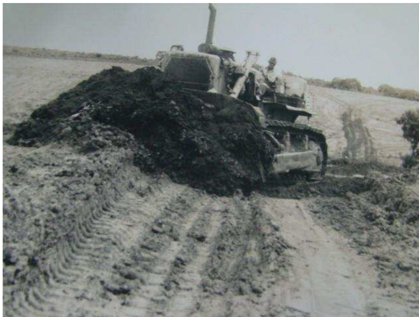
FOTO 10: Avanço do serviço de terraplanagem (1979).
