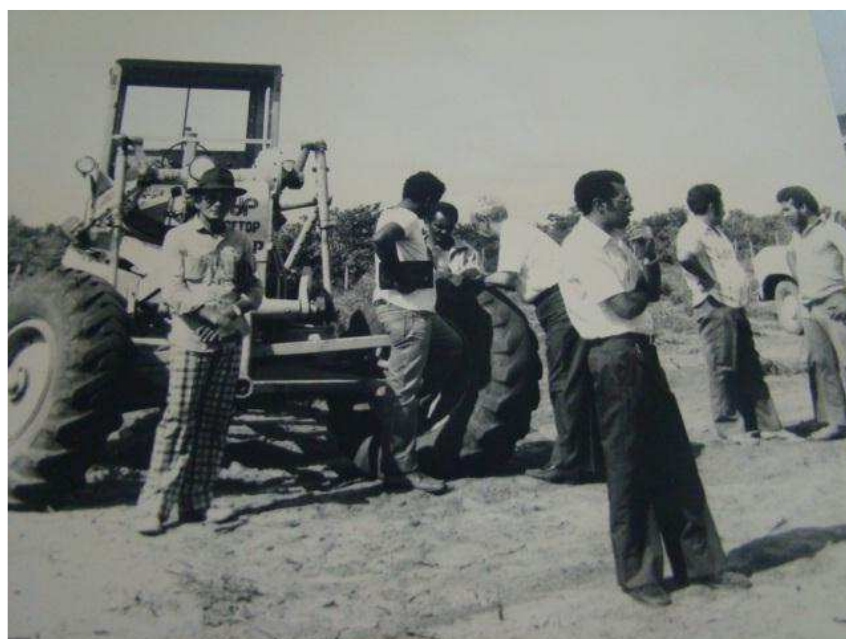
FOTO 5: Chegada das máquinas da construção.
