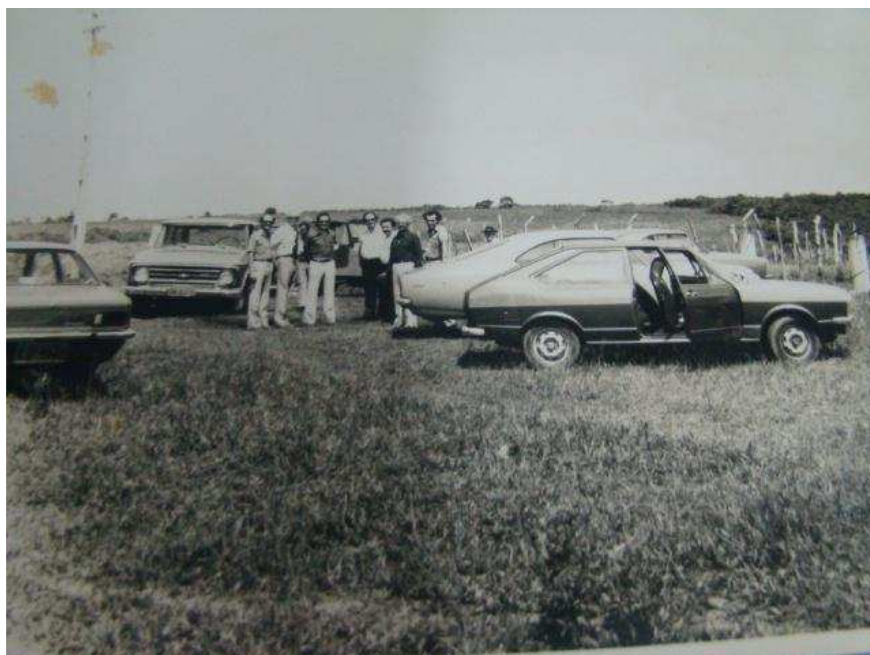
FOTO 7: Dirigentes e equipe técnica vistoriando as obras.
