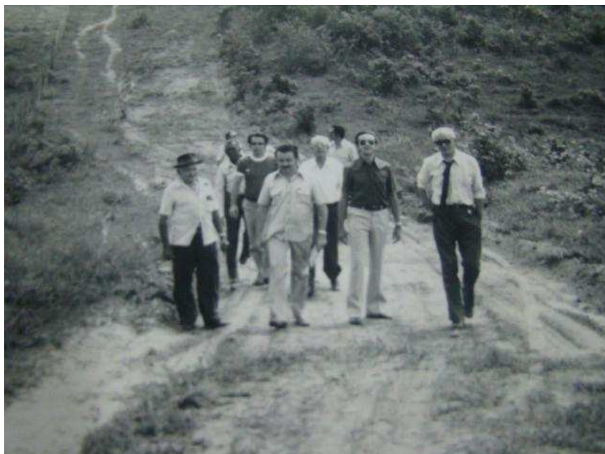
FOTO 8: Visita dos fundadores do UNIPÊ ao local da construção: a dimensão do terreno.
