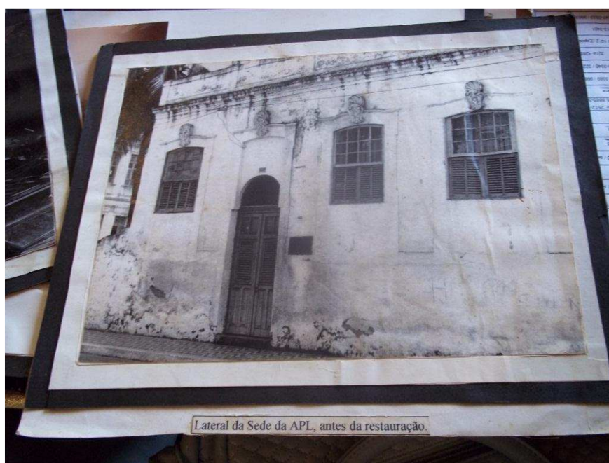
FOTO 21: Lateral da sede da APL antes da restauração
