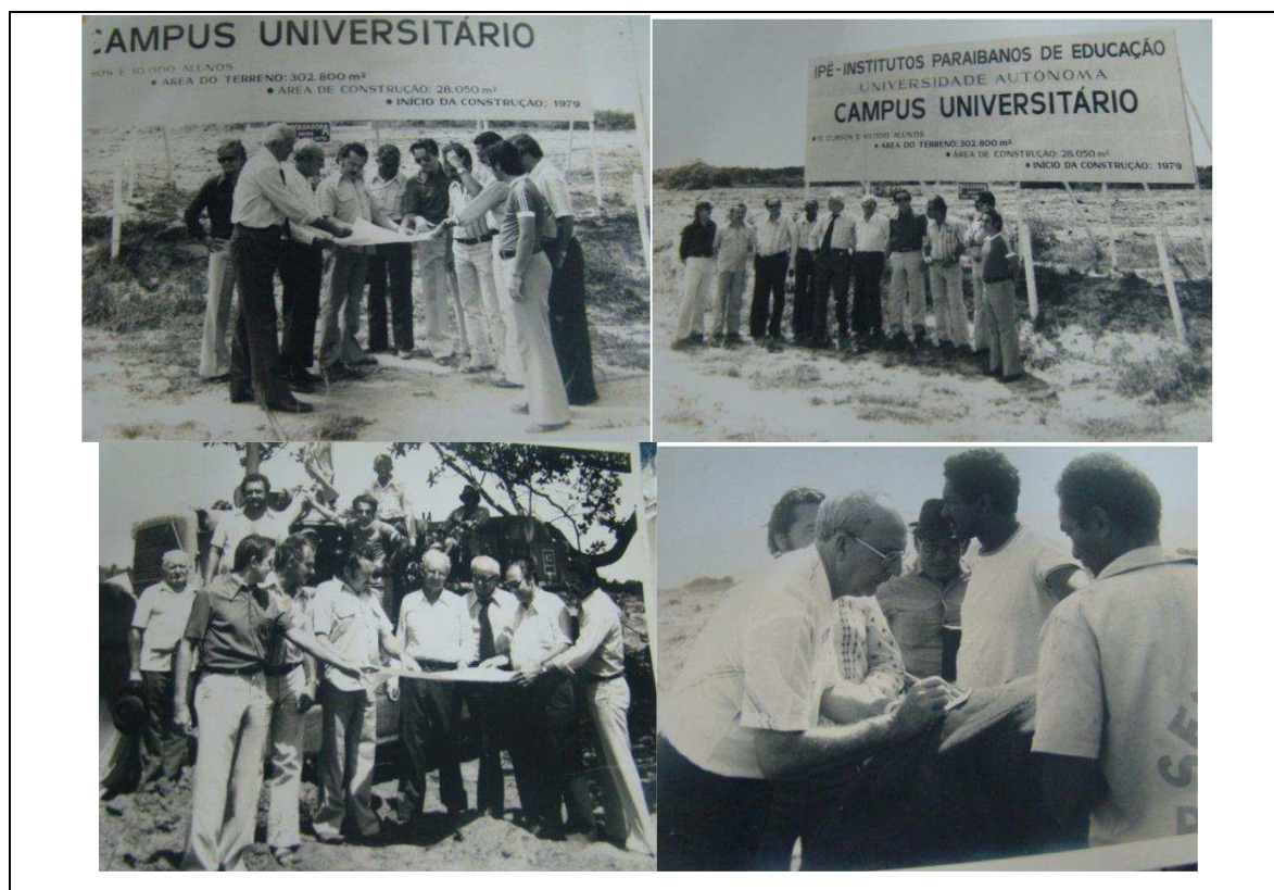
FOTOS 4: Acompanhamento do projeto de construção in loco .
