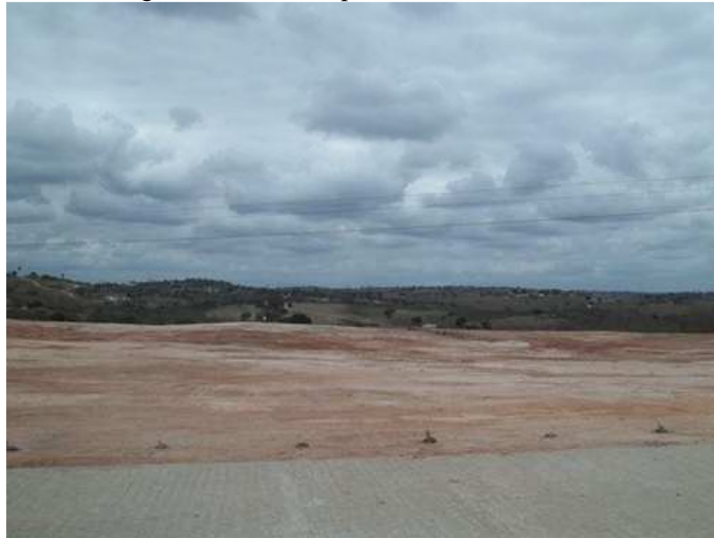
Figura 12: Área ampliada do aterro
