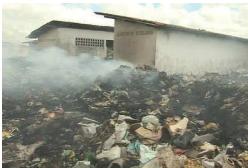
Figura 11: Área interna da usina no período sem funcionamento
