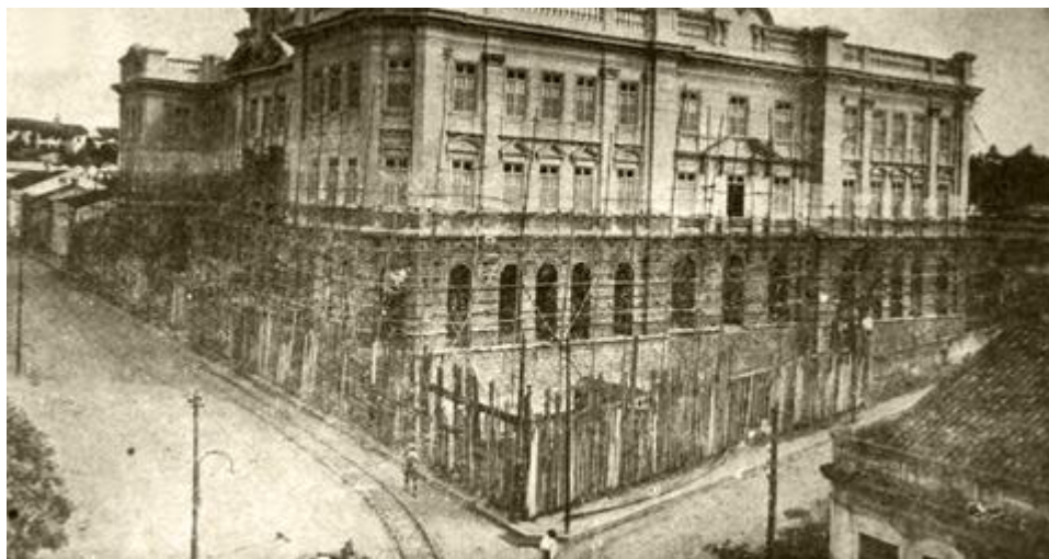
Foto 05: 1925- Prédio dos Correios e Telégrafos.
