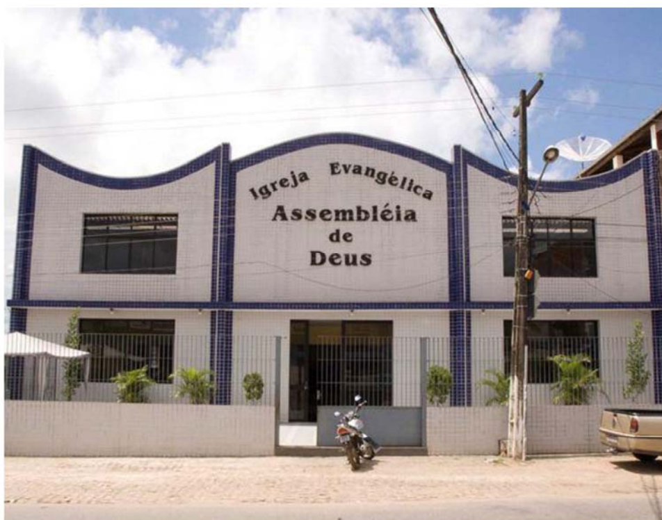
Figura 04 – Imagem frontal da Igreja Evangélica Assembleia de Deus. Av. Ruy Barbosa, Centro de Guarabira/PB. Fonte: Portal Independente/Maio/2013.
