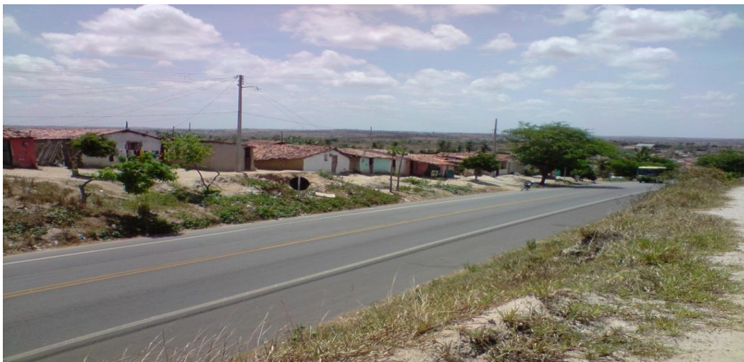
Figura 8: Área segregada as margens da rodovia Federal - BR 104 Fonte: Pesquisa de campo: (Dezembro/ 2010)
