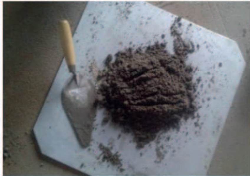
Figura 2 – Preparo da Argamassa Manualmente
