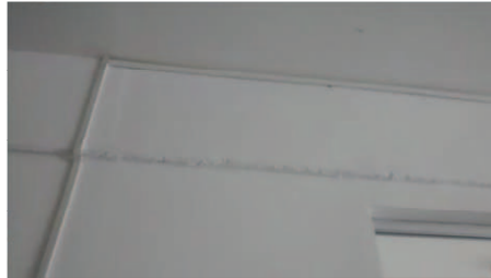
Figura 14 - Instalações Elétricas do Laboratório
