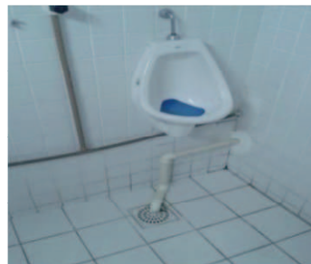
Figura 19 - Mictório do banheiro
