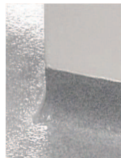
Figura 7 - Junção entre piso e paredes recomendado
