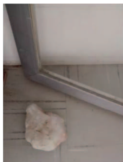
Figura 6 - Junção entre piso e paredes.
