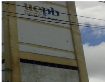
Figura 22 - Caixa d'água que disponibiliza água para o laboratório.
