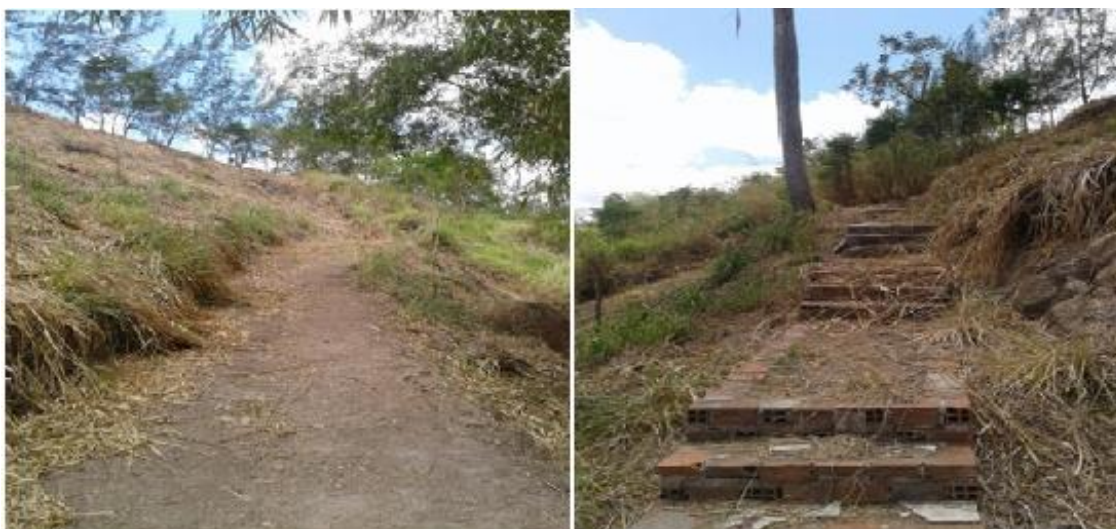
Figura 2: Início da Construção do Espaço ZEN.
