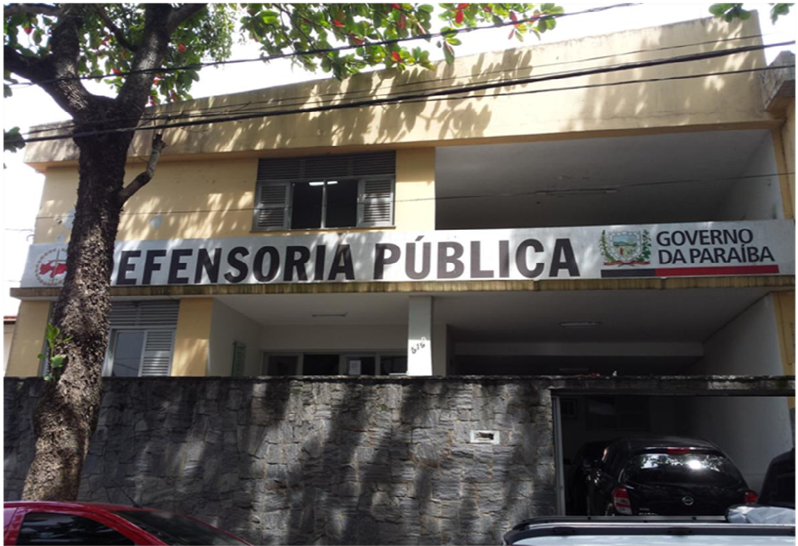
Fig. 01 - Prédio da Defensoria Pública - situado na Rua Deputado Álvaro Gaudêncio, nº 519, Centro de Campina Grande-PB.
